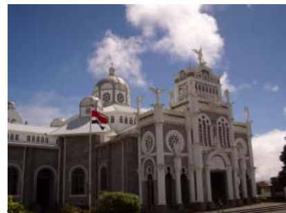
La Basilica de Nuestra Señora de Los Angeles, qui renferme la Negrita, est construite avec une armature d'acier recouverte de béton et de stuc.
