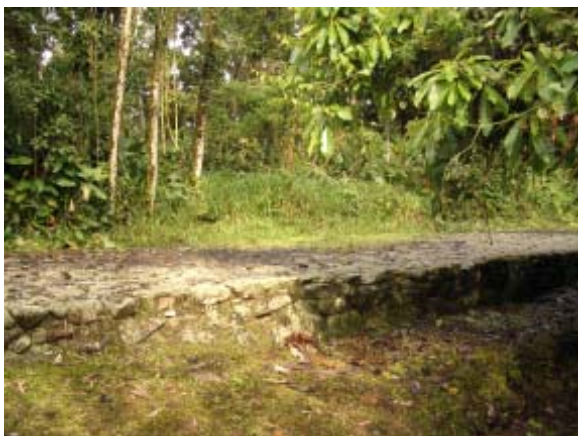
La chaussée vue de côté.
